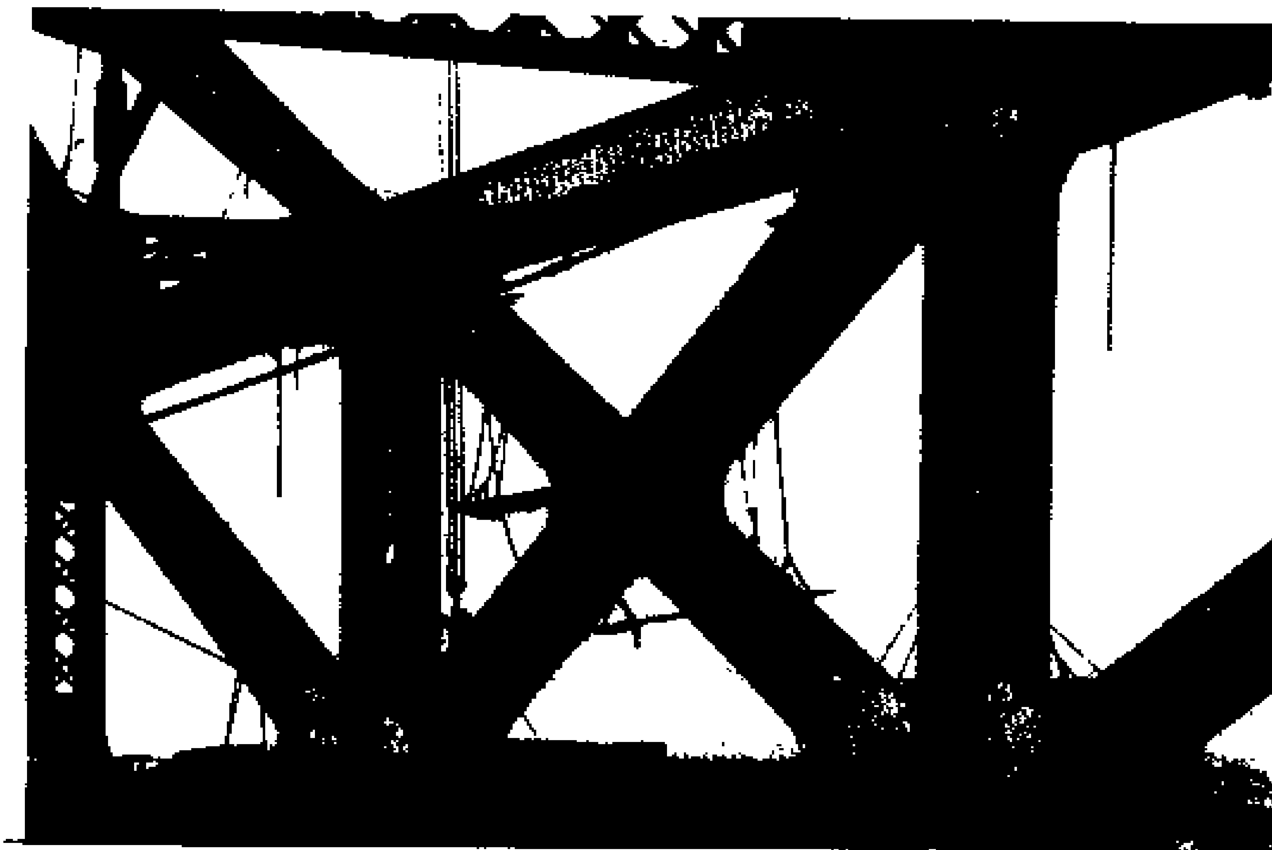
图201. 钢铁联合公司造的钢结构
