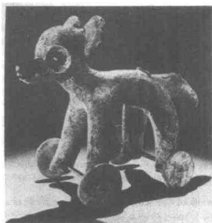
图 1.2 阿兹特克人制作的有轮泥塑(墨西哥)。凡是在中美洲出土的动物小泥塑都运用了轮和轴的工作原理。这些泥塑是从公元 300 年至 16 世纪西班牙人到来之前制作的,这段时期在这一地区不存在有轮交通运输工具。资料来源:斯图亚特·皮戈特著,最早的有轮交通(Ithaca, N. Y., 1983),原 15 页,NEG.NO: 326744;美国自然史博物馆图书服务部惠准复制此原。
