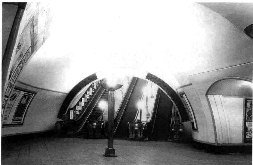
图 10.3 特恩派克巷地铁站的电梯隧道，开放于 1932 年。位于皮卡迪利延长线上的车站的宽敞和庄严象征着地铁出行的新时代。
