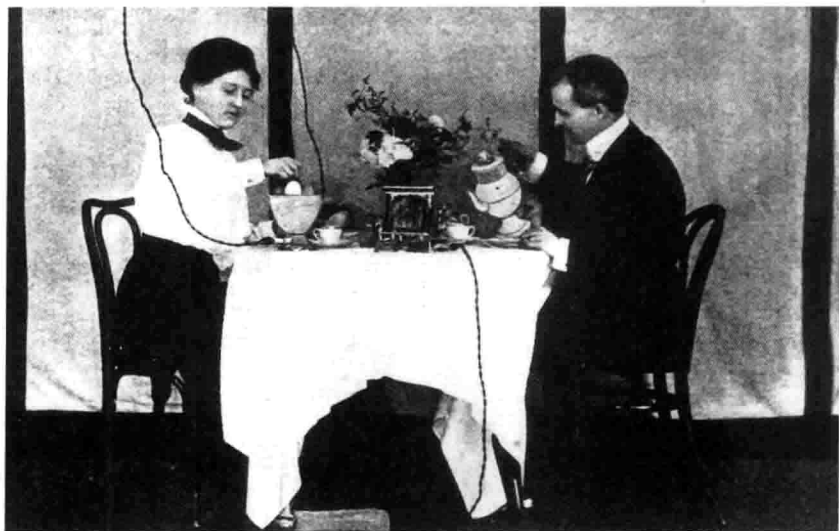
图 8.6 电气化早餐，1914 年。使用中的电咖啡壶、烤面包机和煮蛋器。对于供应管理工程师而言，电气烹饪的早餐的吸引力在于它是在需求低的时候使用电能。摘自 Mrs. Lancaster, Electric Cooking, Heating, Cleaning, etc. , 1914。
