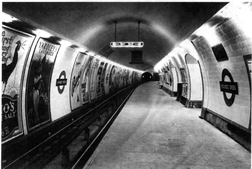
图 10.5 站台，邦兹格林站，1932 年。站台设计的改进赋予了站台隧道平滑的表面，改善了照明，站名标志与海报区别明显。
