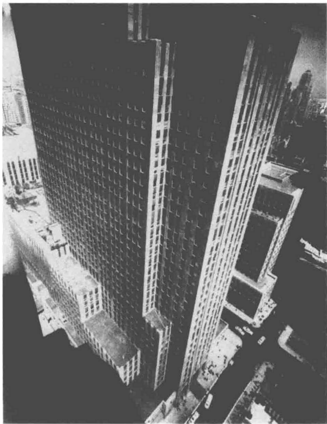
图 211 从时代—生活大楼楼顶看洛克菲勒中心。安德烈亚斯·费宁格摄影
