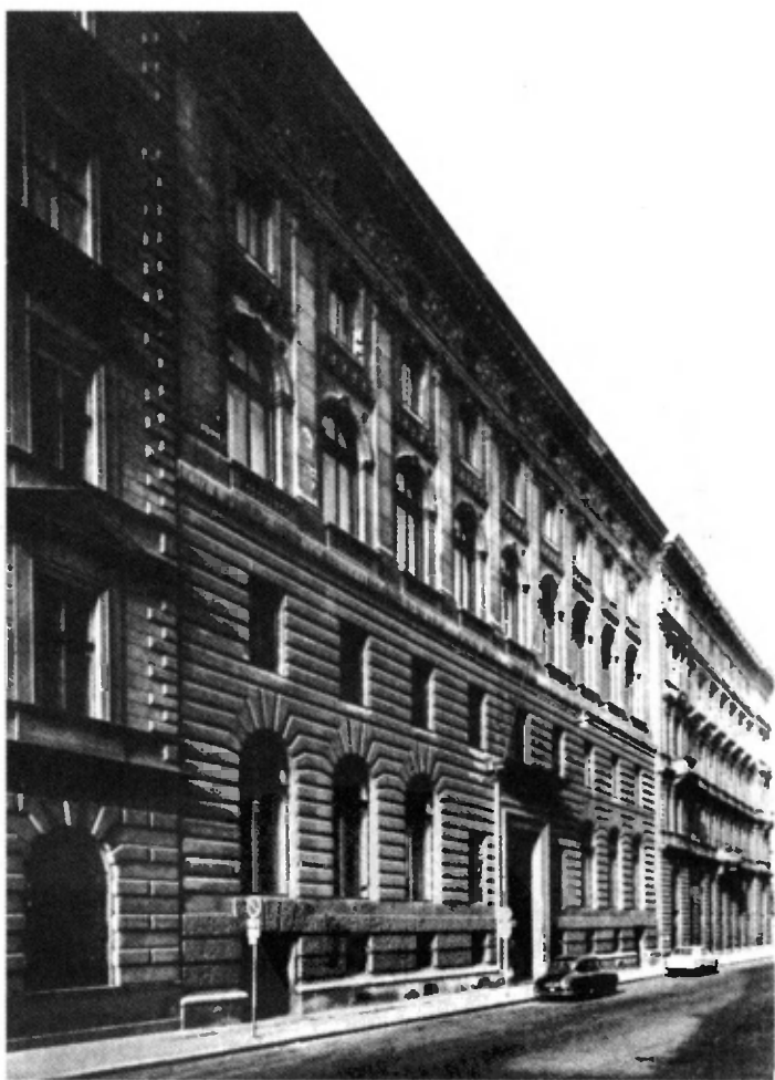
图18 奥托·瓦格纳设计,奥地利土地银行大楼,1882-1884年,临街外观。
