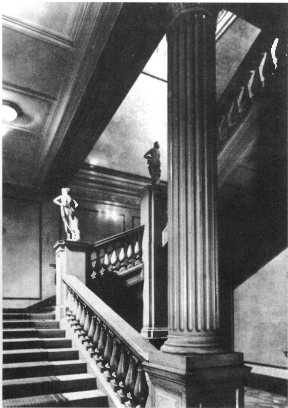
图 11 卡恩特纳环路 14 号的楼梯间,1863—1865 年。
