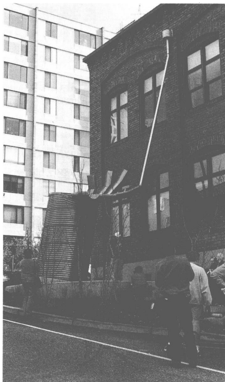
招手水槽為藤蔓小溪儲蓄了重要的水源。照片由吉姆·迪爾斯拍攝。
