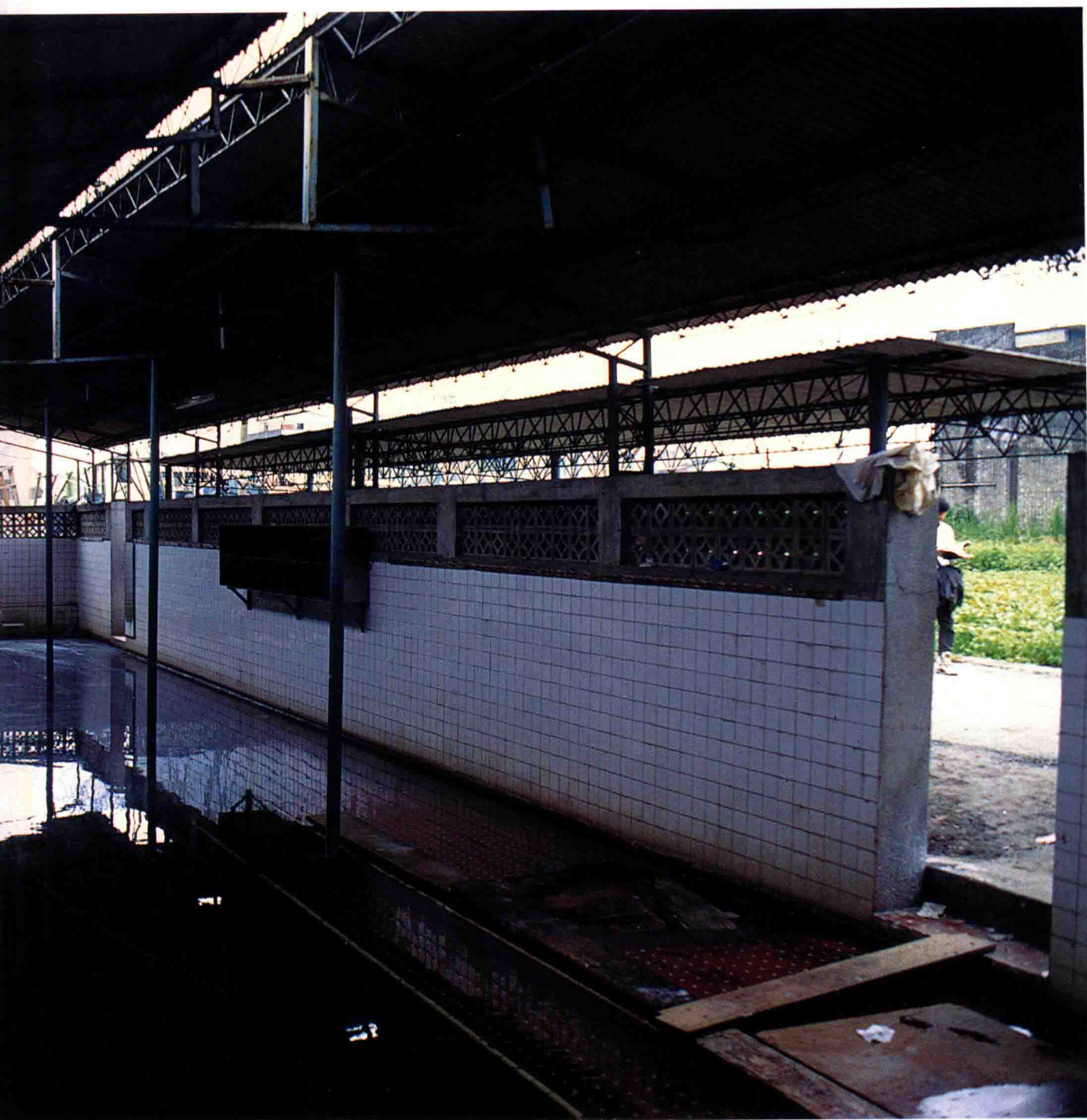
• 礁溪溫泉溝公共浴池內部
