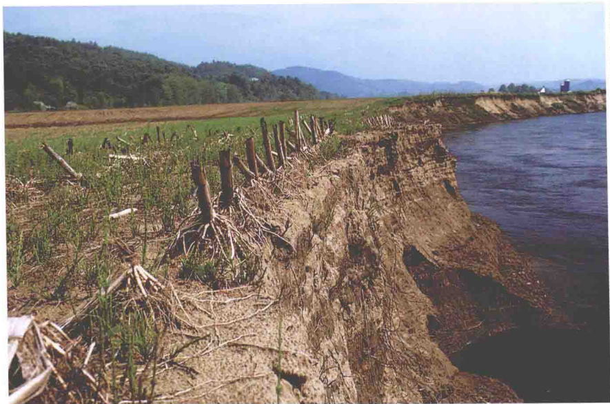
严重的土地侵蚀
