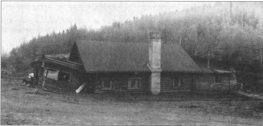
图 18.9 (a) 地表原有植被的清除对于永久冻土地带深度的影响; (b) 房屋的取暖造成永久冻土的融化从而进一步导致地面沉降
