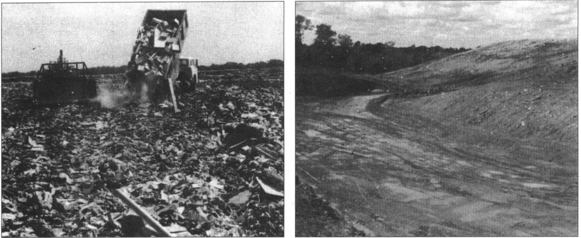
图 5.10 清洁的垃圾掩埋操作。大量的垃圾（左图）被堆起，并在其中添加黏土夹层。最后的垃圾堆（右图）在覆盖了一层几英尺厚的土壤后种上植物
