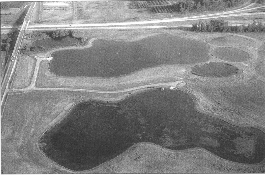
图 6.8 一个小型社区的污水系统——利用一系列的湿地水池来处理污水
