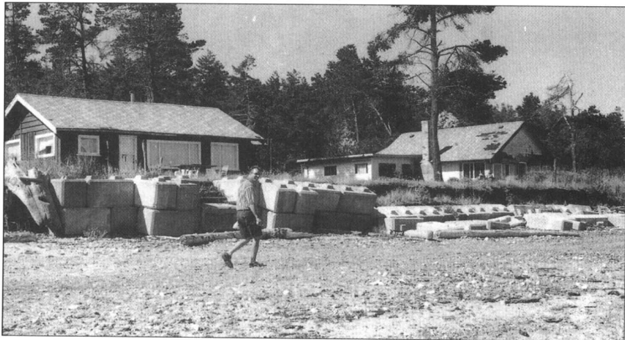
在清理掉大型木头碎片和树木之后的海滩上建造起来的失败的防波堤,注意右侧海岸更为严重的侵蚀
