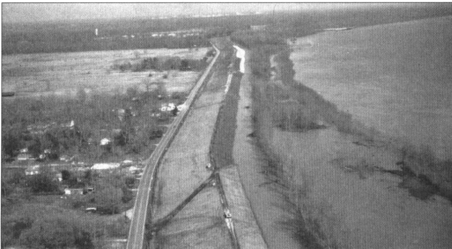
图2.11 路易斯安那州南部沿密西西比河的防洪大堤 (图中白线间的区域)。图左侧的河漫滩常常低于河面
