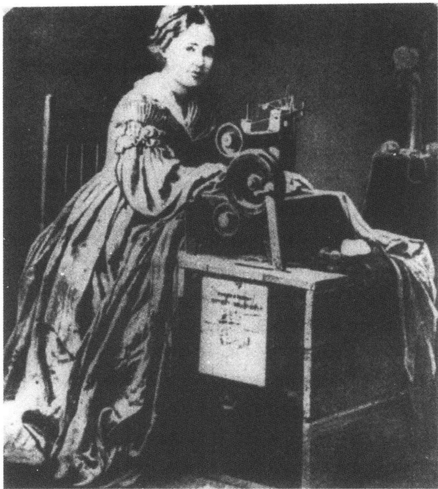
图 4.2 1851 年辛格 (Singer) 缝纫机的第一台专利样品。它的粗糙直白形式是给发展了“机器美学”观念的早期现代主义设计师带来灵感的典型形式之一。
