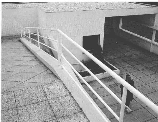
“萨伏伊别墅”从空中庭园连接至日光浴房（solarium）的斜坡
