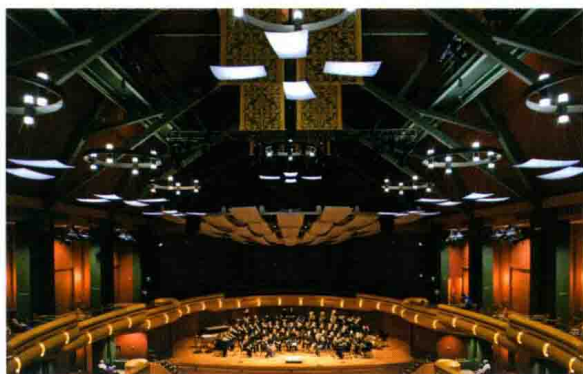
图12.16 圣母大学巴托罗表演艺术中心的莱顿音乐厅。其混响时间可以通过改变天花板上的板材和横幅的位置以及侧面的布帘来调整。
