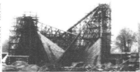
图六：建设中的菲利普斯馆（图上是沿着边框组装一部分混凝土嵌板的过程）
