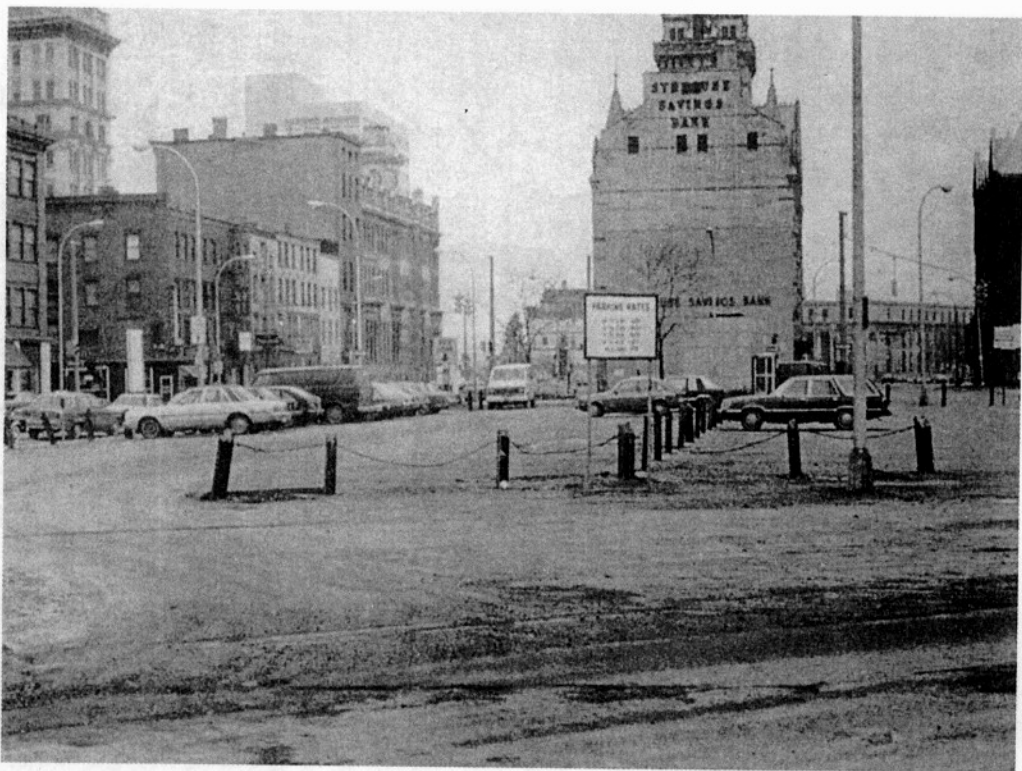
图 1-3 纽约锡拉库扎地区遭到破坏的步行空间，1984 年城市中的步行受到道路和停车场的阻隔，行人常常感到不愉快和无方向感。（摄影：James R.Chrisfield）
