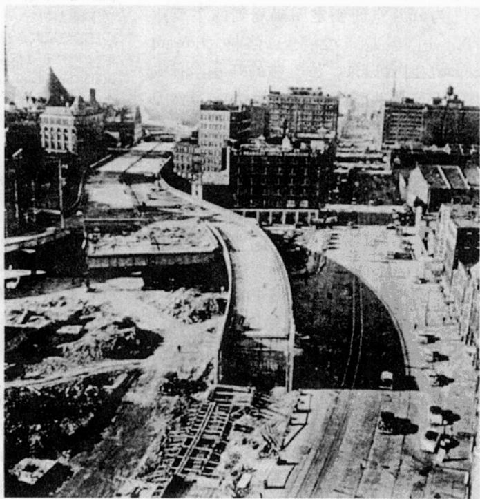
图5-9 建设中的中央干道 20世纪50年代，中央干道及其支路的修建是波士顿市区中心的一大败笔，无数的商业和居住建筑被拆除来修建这条高架路，并形成了核心区和港区之间一道不可逾越的障碍。（引自 Benevolu, History of Modern Architecture, 照片提供：Courtesy MIT Press）
